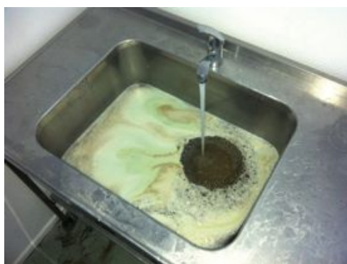
Anlegg med oppløste kalkavleiringer.
