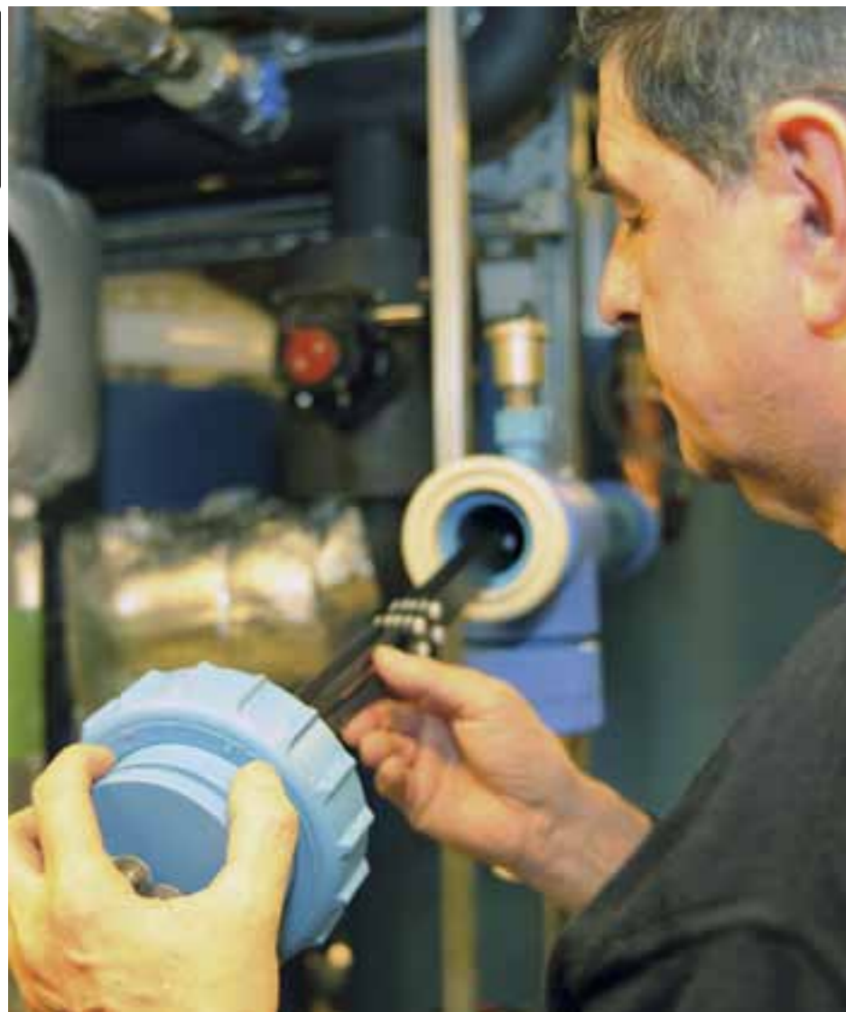
HJERTET: Oppfinner Wolfgang Strele viser fram rør i rør-anoden som sørger for anodisk oksidasjon som dreper Legionella og andre typer bakterier.
