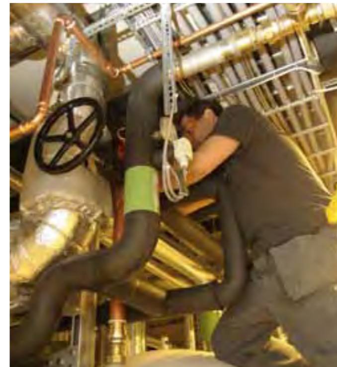
KOBLER: Kjell Henry Myhra monterer vannrør inn på den ene Anodix-enheten ved sykehuset i Tønsberg.
